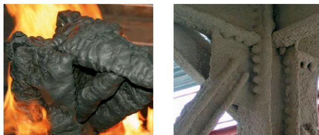
Рис. 3.1. Тонкослойные огнезащитные покрытия
