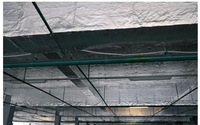
Рис. 4.1.а. Системы ТН-ОГНЕЗАЩИТА Металл с декоративным покрытием
