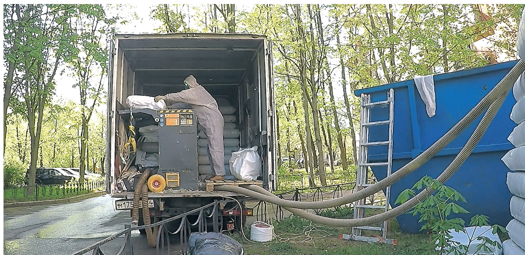
Рисунок 8. Рабочее место оператора разрыхлительно-выдувной установки
