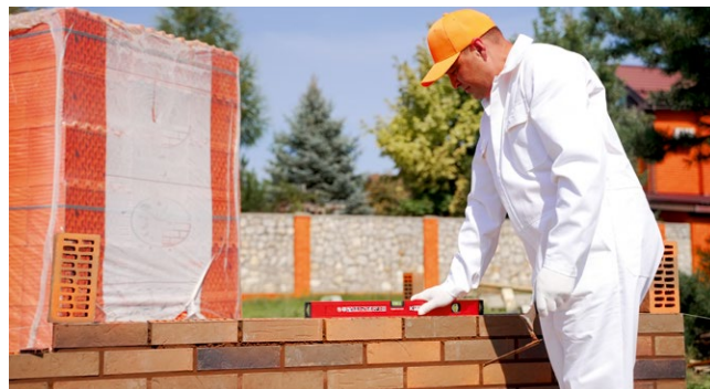
Рис. 2.2. Возведение кирпичной кладки
