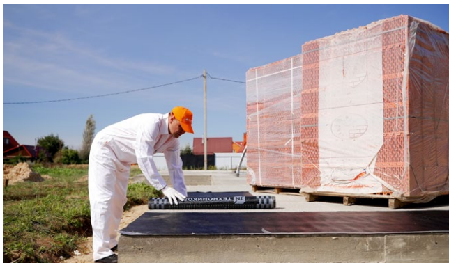
Рис. 2.1. Подготовка основания фундамента
