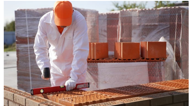
Рис. 2.6. Возведение внутренней несущей стены
