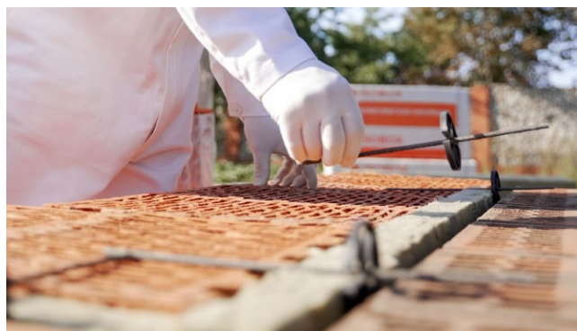
Рис. 2.9. Установка гибких связей
