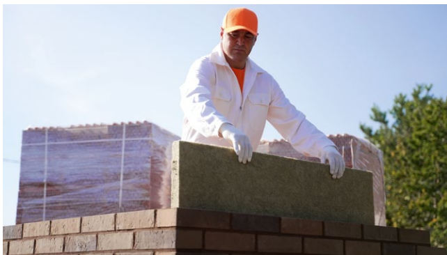
Рис. 2.8. Монтаж плит ИЗОБОКС ИНСАЙД
