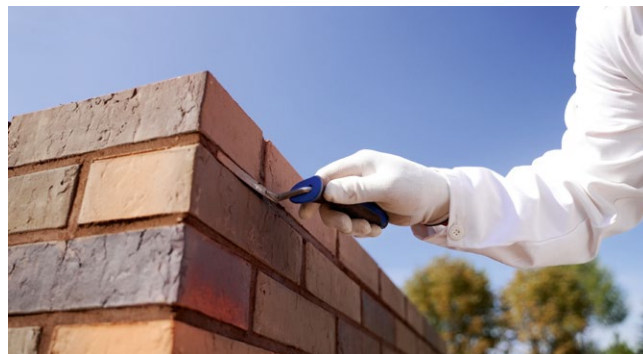
Рис. 2.3. Расшивка швов кельмой
