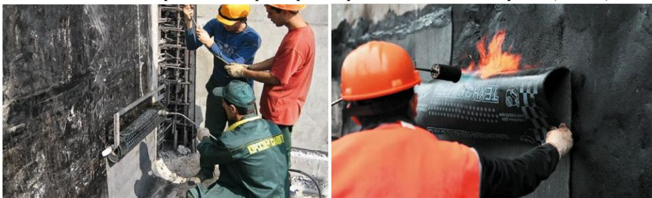
Рис 2.2 Метод сплошного наплавления.
