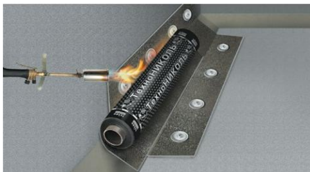
Рис. 5.6 Наплавление рулона на слой усиления
