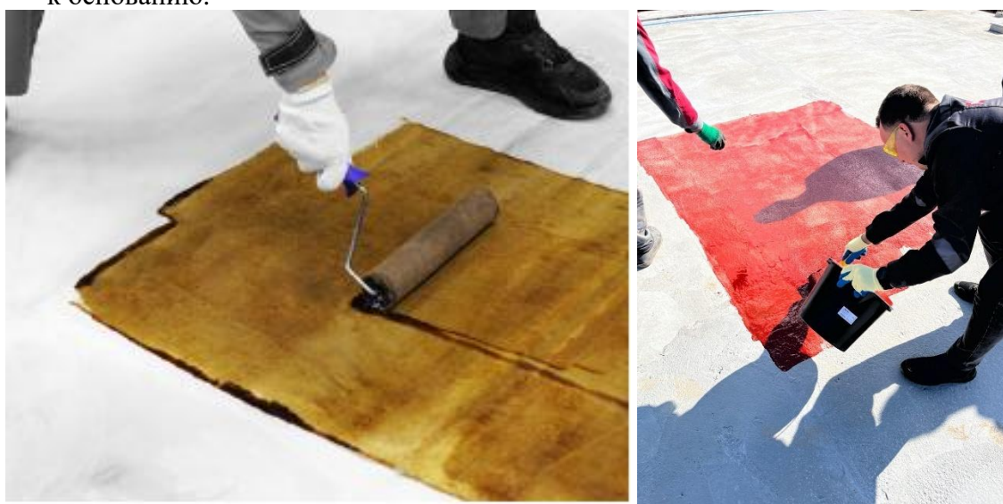
Рис. 3.3. Нанесение праймера.
