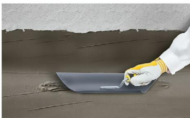
Рис. 3.2 Устройство выкружки
