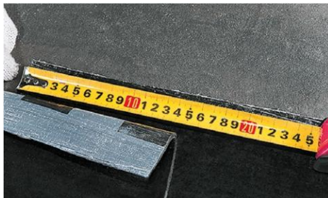
Рис. 4.4 Контроль торцевого нахлеста при укладке материала Техноэластмост Б
