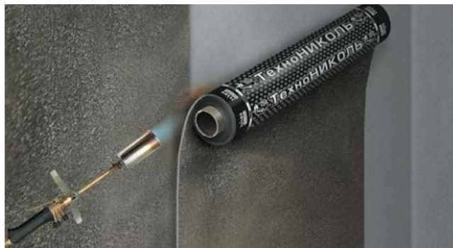
Рис. 4.5 Сварка нахлестов с последующей механической фиксацией рулона
