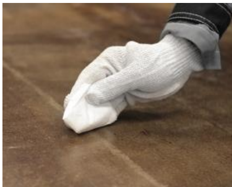
Рис. 3.4. Определение высыхания праймера
