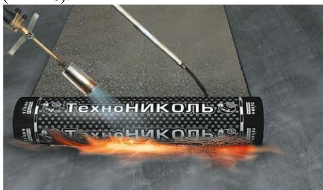
Рис 4.8 Наплавление рулона.
