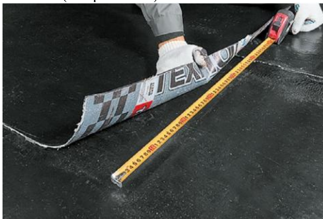
Рис. 4.11 Выставление нахлеста между рулонами первого и второго слоев
