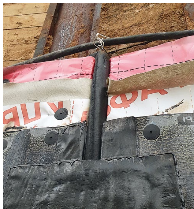
Рис. 7.17. Устройство гидроизоляционной мембраны в зоне перехода котлована с вертикальным ограждением на котлован с откосами
