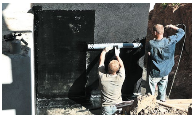
Рис. 4.17. Ручная и механическая подача рулона
