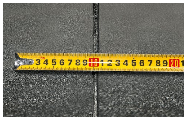
Рис. 4.10. Вытек битумного вяжущего из-под кромки материала
