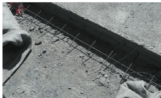
Рис. 4.11. Защитная стяжка
