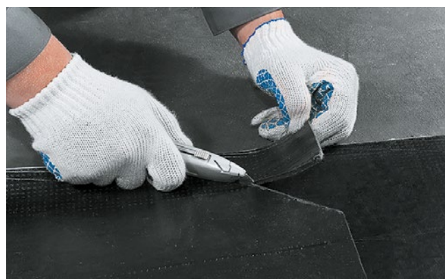
Рис. 4.5. Подрезка угла рулона в Т-образном шве
