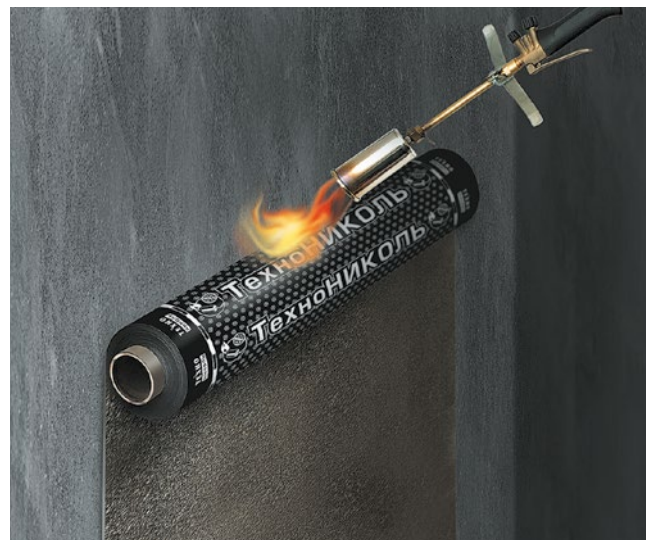
Рис. 4.18. Наплавление битумно-полимерного рулонного материала на вертикальную поверхность
